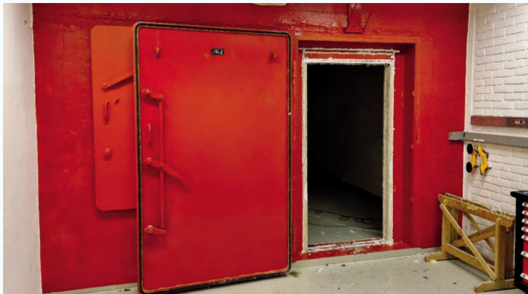
Dør- og vinduslaboratoriet klart for innsetting av dør til prøving. Vindusåpningen kan ses lukket til venstre.
