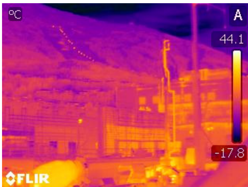
Figur 40: Pumpestøp av vegg til nye Narvik Brannstasjon. SINTEF Narviks kontorer i bakgrunnen og alpinanlegget i det fjerne. 16.12.2020. Betongen har nådd 2/3 høyde i veggforskalingen.
