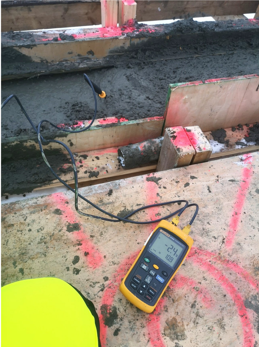
Figur 33: En av delmålingene for gjennomsnittsberegning. Utført med 15 cm lang "probe". Her er det 10,9 °C i betongen og -2,4 °C lufttemperatur.
