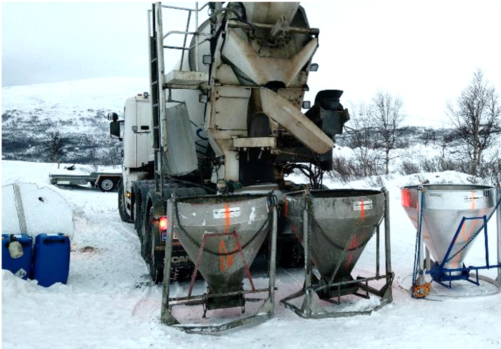
Figur 26: Klargjøring til flyving på Altevann. Isolert lokk kilt fast mellom fuelkanner til venstre, vintertobbe til høyre, godt brukte standardtobber i midten
