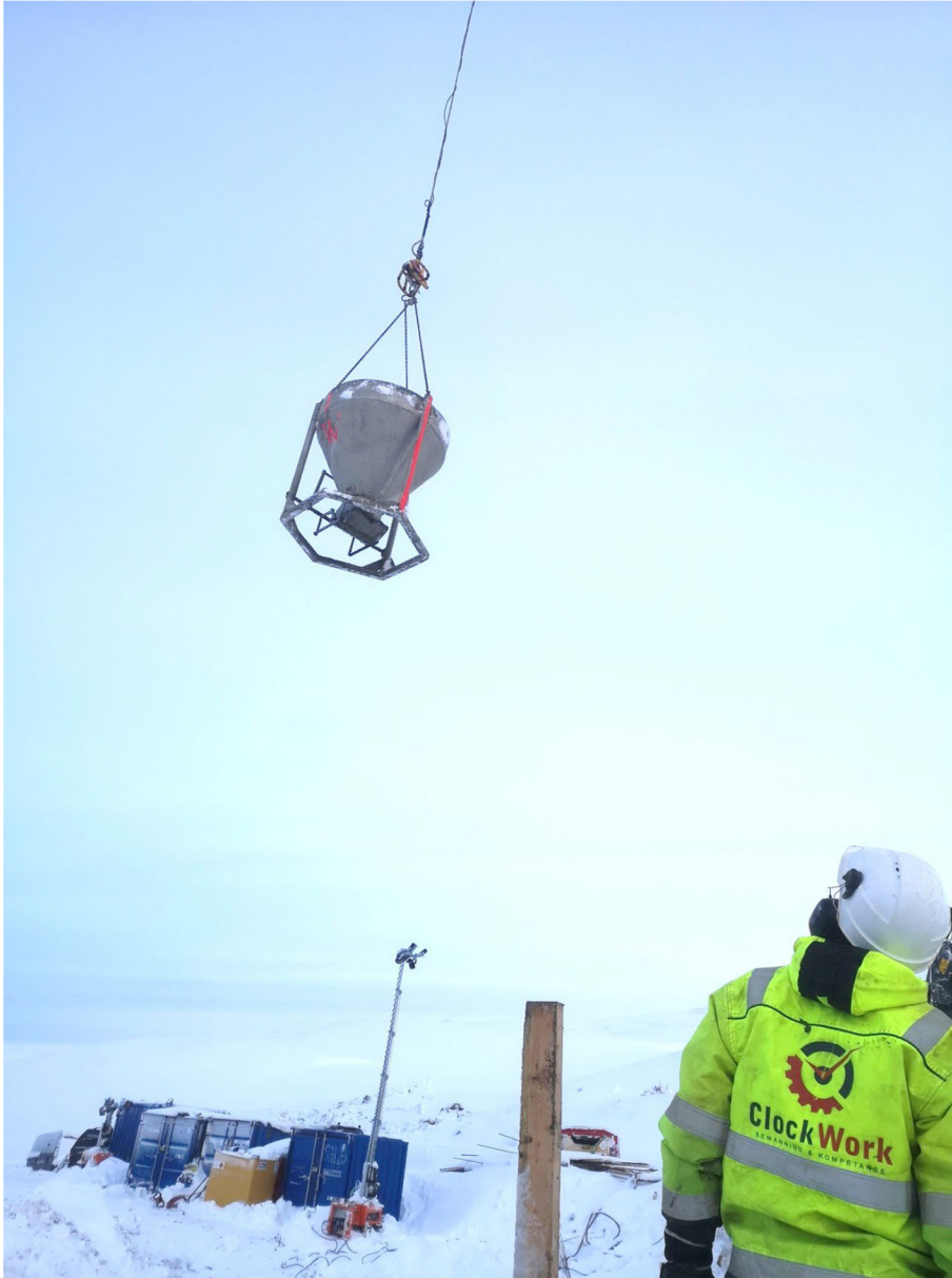
Figur 30: Ankomst forskaling med utløser bakover
