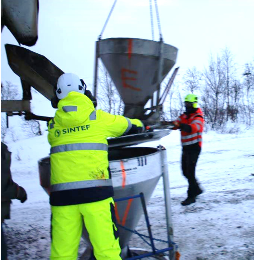
Figur 35: Hektisk aktivitet på lasteplass. Mottak av tom standardtobbe, samtidig som lokk monteres på ferdigfylt vintertobbe. 16.12.20
