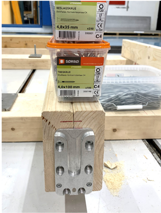
Figur 57 Prøveoppstilling Q. Beslagsdel montert i endeved
