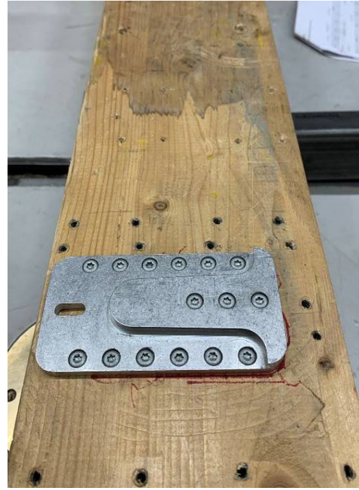
Figur 58 Beslagsdel montert til limtre
