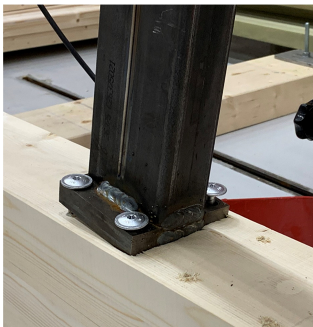
Figur 28 Uttrekk og trykkbrudd ved bruddlast, test 4
