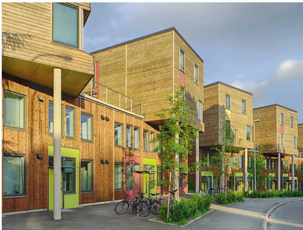
Byggforskserien gir kunnskap for å vurdere og planlegge bygging med moduler. Her er et eksempel på modulbygg - Berg studentby i Trondheim. Arkitekt: Skibnes Arkitekter AS. Foto: herzog/visualis-images.com
