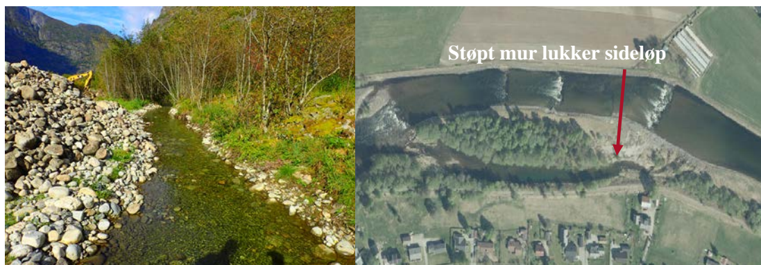
Figur 34: Gjenåpnet sidebekk ved Voll (segment 9) og sideløp oppstrøms øvre del av Lærdal sentrum (segment 2) som fremdeles er lukket grunnet en gammel støpt mur. Sideløpet har ingen årssikker vannføring og gir dårlige vandringsmuligheter for fisk.
