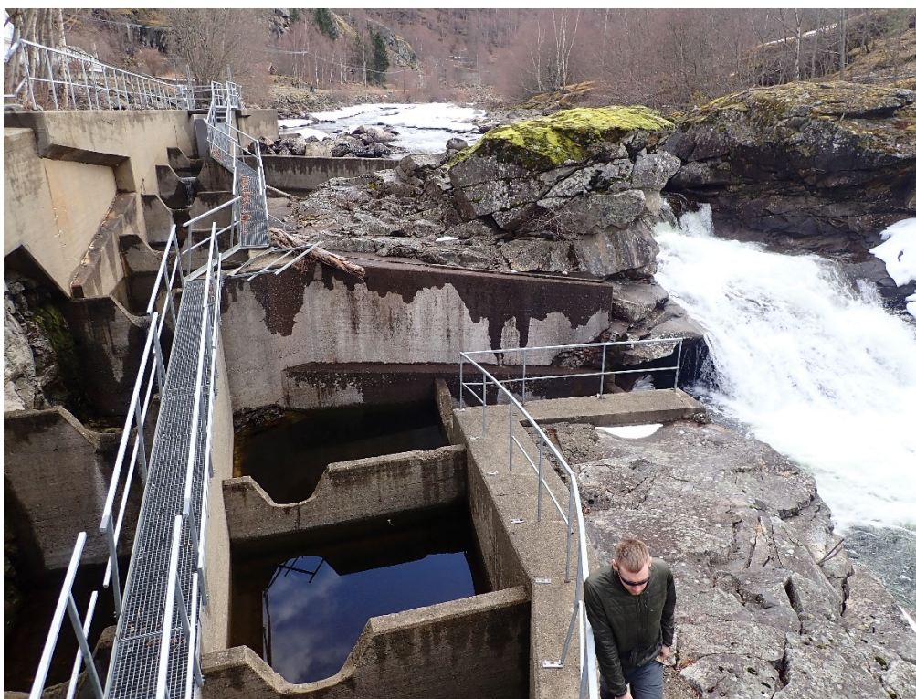
Figur 15: Fisketrappa i Husumfoss med inngangen (øverste bilde) plassert ved fossefoten innunder berget, videre opp mot toppen (nederst). (Foto: S. Stranzel, NORCE).
