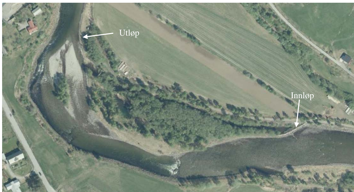
Figur 57: Det er kulvert inn i kilen som må justeres for å sørge for årssikker vannføring.
