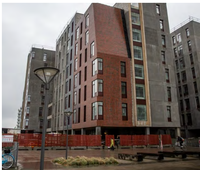
Generasjonenes hus under bygging
