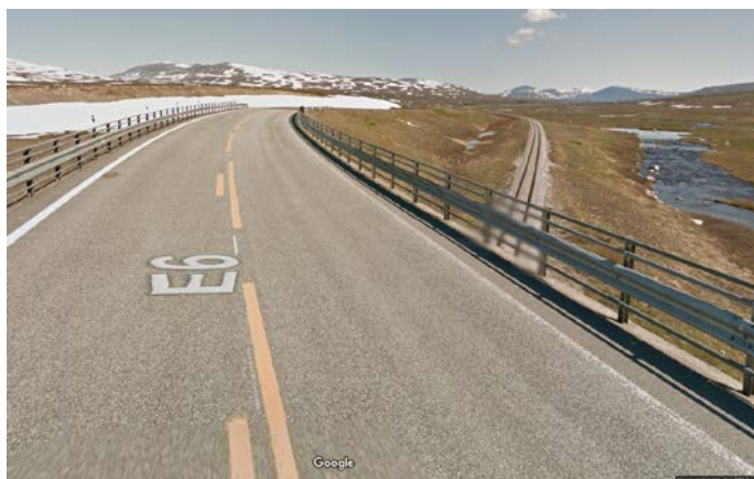
Figur 4: Bro med kryssing av jernbane.
