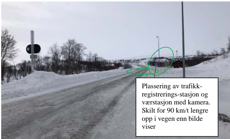
Figur 11: Sørover fra innkjøring til Brøytestasjon, ved sted B2 i Figur 7. Foto: SINTEF
