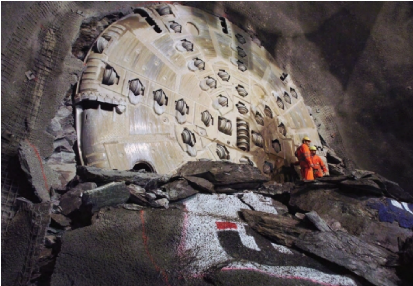
Prognosering av TBM-ytelse, kutterslitasje og fremdriftsevne inngår i berglaboratoriets suite av borbarhetstester (DRITM, BWITM og CLITM). Her ser vi TBM-kutterhodet etter gjennomslag ved prosjektet Ceneri Base Tunnel i Sveits. Den samme maskinen ble senere benyttet ved Statkrafts prosjekt i Røssåga. Foto: Courtesy of the Robbins Company
