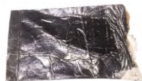
Eldre dampsperre, trolig fra 1962. Diffusjonstett bygningspapp med foliebelagt fremside.
