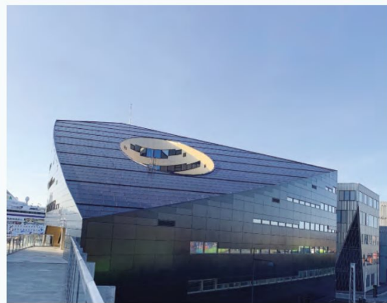
Det blir installert stadig flere solcelleanlegg i Norge, og installert kapasitet økte med 29 % bare fra 2017 til 2018. Men hva med brannsikkerheten? Bildet viser Powerhouse Trondheim. Foto: SINTEF
