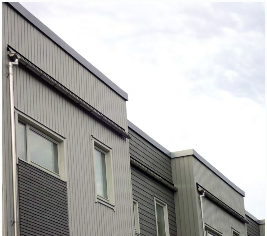
Montering av utvendige takrenner og nedløp fra flate tak kan være utfordrende.
