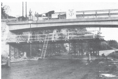
Figure 21. The Stora Höga Bridge 1 (Plos & Gylltoft 1995).
