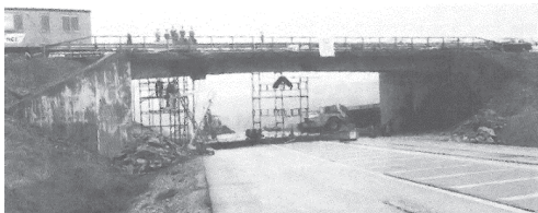
Figure 23. The Stora Höga Bridge 2 (Plos & Gylltoft 1995).
