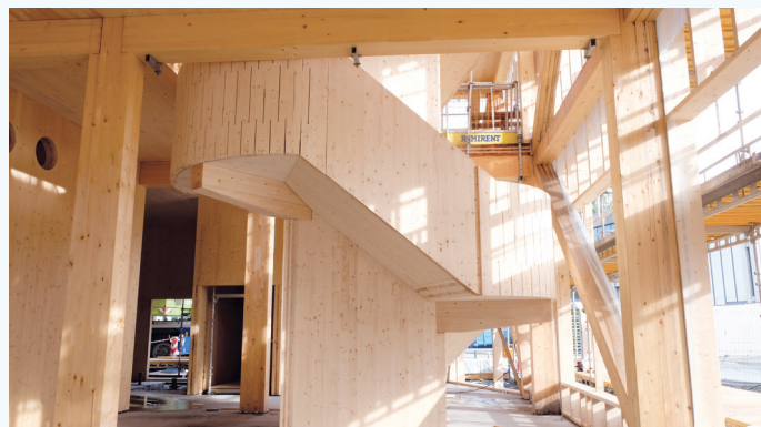
Hovudtrappa i ZEB-laboratoriet er utforma med eit ønske om å bruke minimalt med stål.
