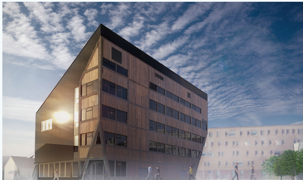
ZEB-laboratoriet til NTNU og SINTEF er under oppføring på Gløshaugen i Trondheim.
