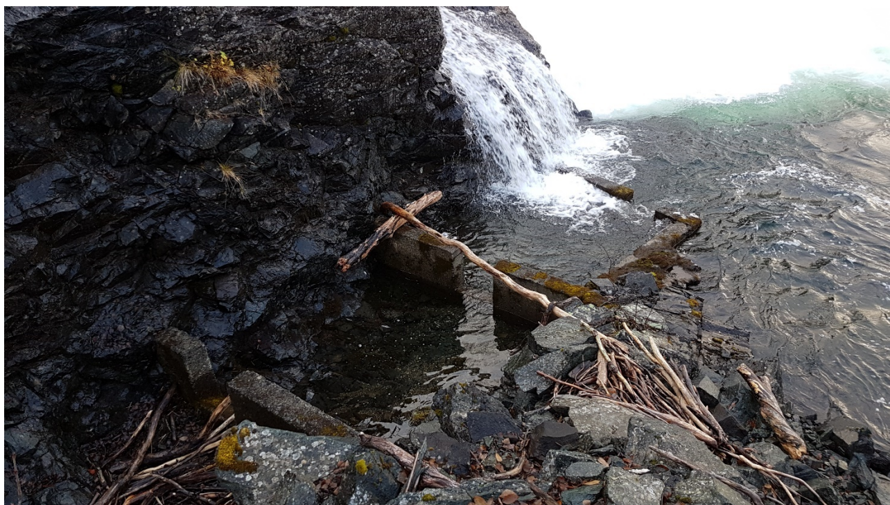
Figur 10. Inngangen til fisketrappa i Mellafossen.
