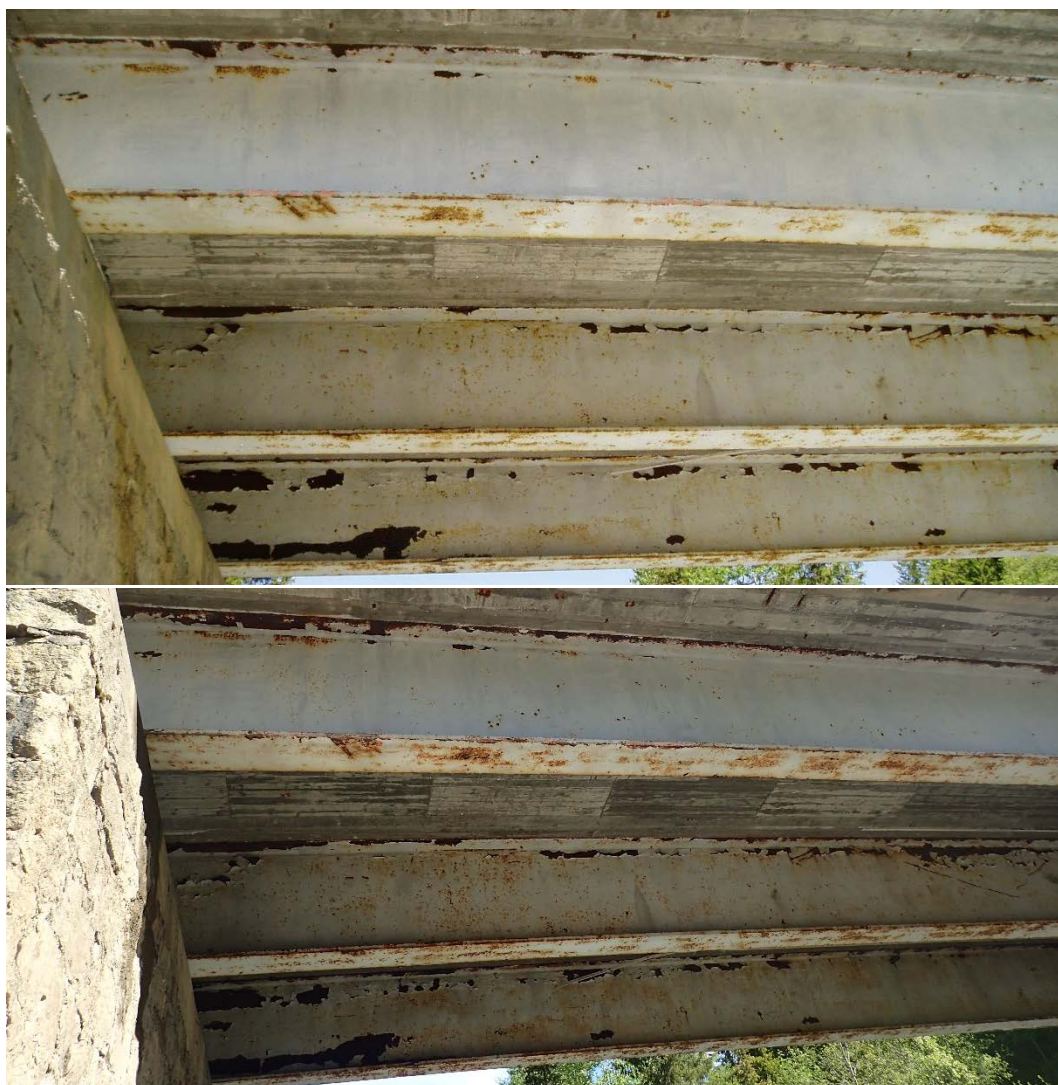
Figur 8. Tilstand til belegg på Ena bru i Midtre Gauldal. Øverste bilde er tatt i 2007 og nederste i 2017
