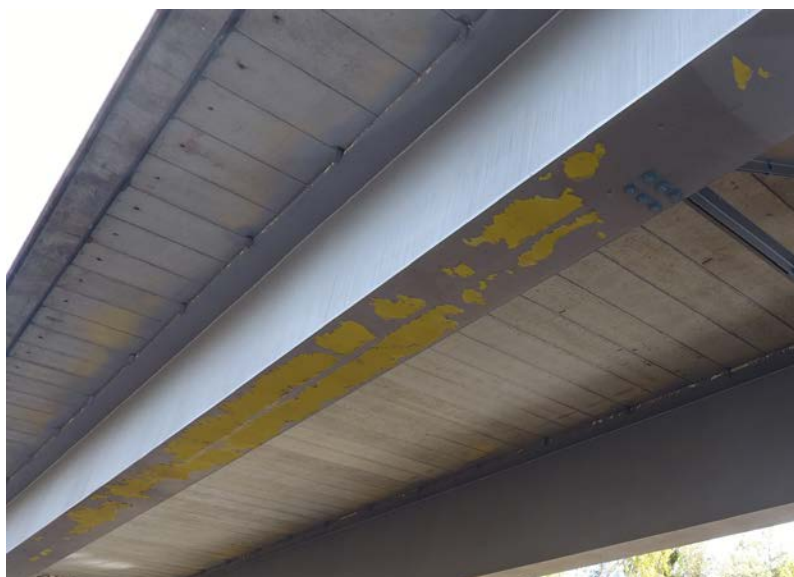
Figur 12. Oversiktsbilde og flassing av toppstrøk på underflens
