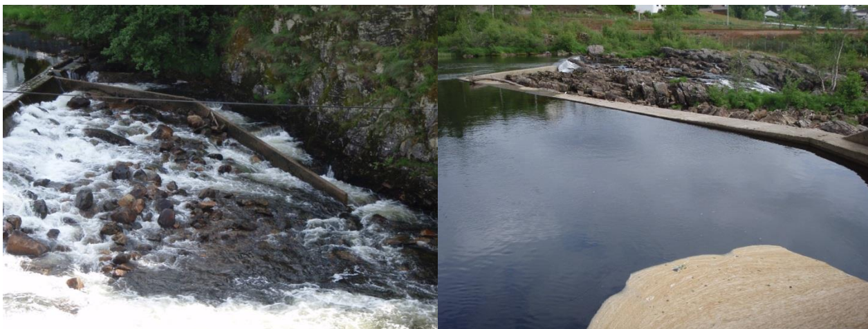
Figur 8. Fisketrappa i Moi sentrum til venstre og inntaksdammen til Moi E-verk i Kvernfossen ovenfor NorDan vindusfabrikk til høyre.
