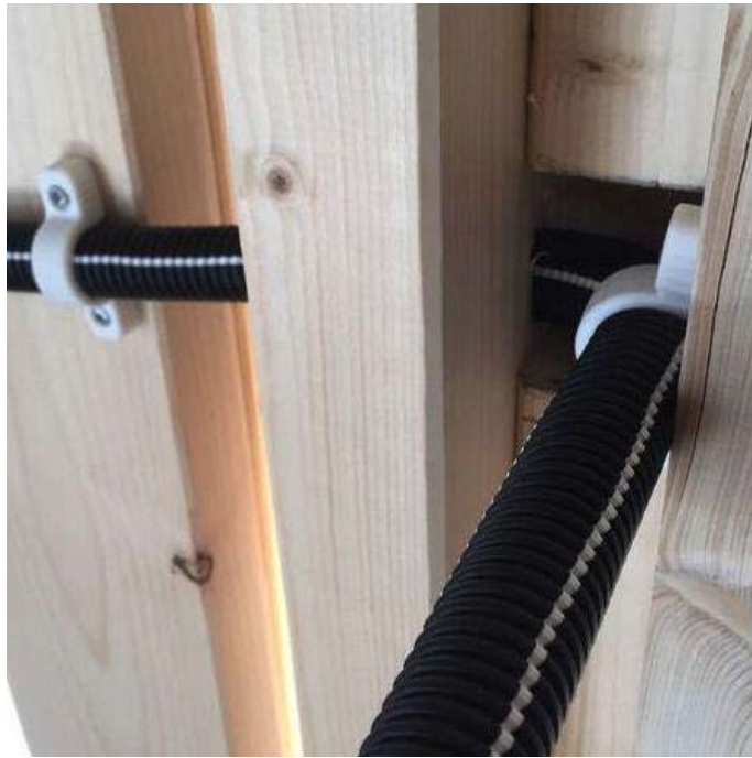
Figur 7 Kraft bend i stenderverk
