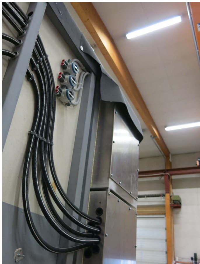
Figur 9 Eksempel på føring fra fordelerskap til tappepunkter
