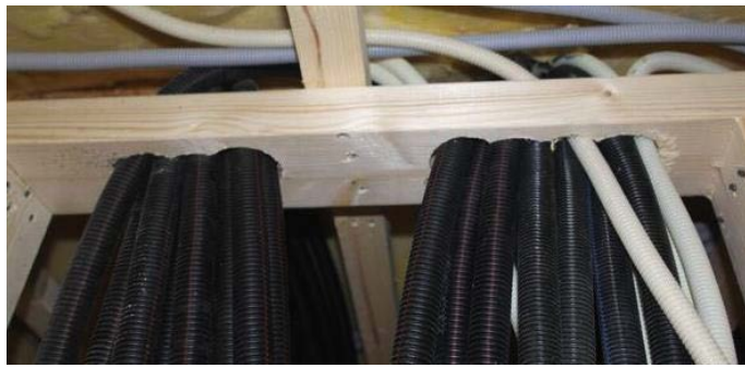
Figur 6 Buntklamring gjennom stenderverk
