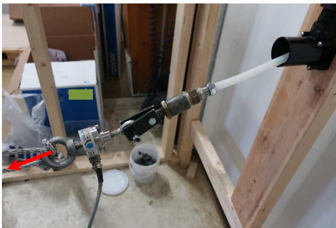
Figur 20 En person trekker for hånd ut røret gjennom veggboks.
