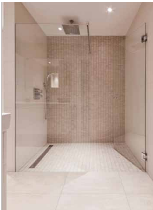
Figur 2: Storformat fliser på golvet, i kombinasjon med samme type flis i småformat i nedsenket dusjnisje forener praktiske løsninger med god avrenning mot sluk.
