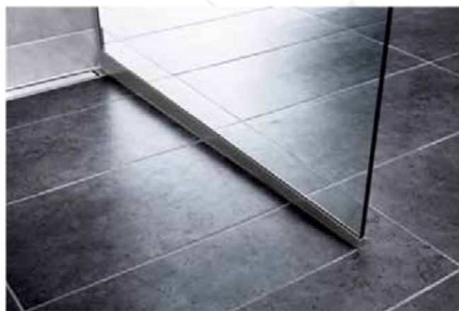
Figur 4: Fliser med ensidig fall, evt. et nedsenket dusjområde avskjermet med glassvegg er en effektiv måte å innfri fallkravene og beskytte resten av området mot vannsøl.
