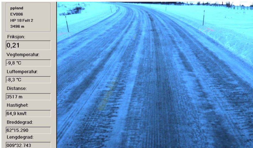
Figur 2.21: Situasjonen før strøing på E6 Hp 18, strekning 5
