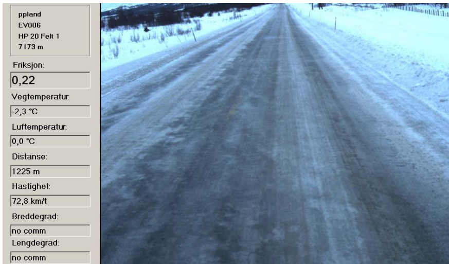
Figur 2.18: Situasjonen før strøing på E6 Hp 20, strekning 1
