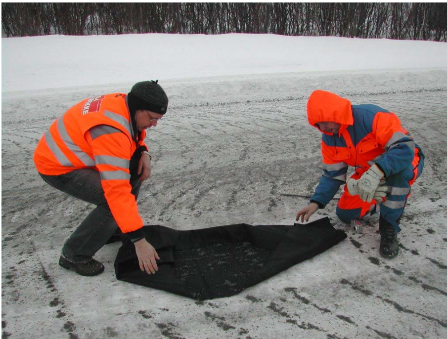
Figur 3.31: Sammenlegging av fiberduken for veiing
