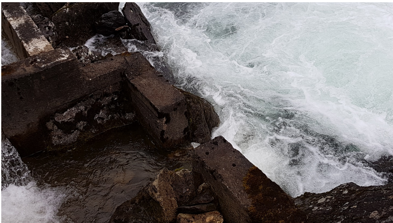
Figur 10. Inngangen til fisketrappa i Øverfossen (uten vannføring).
