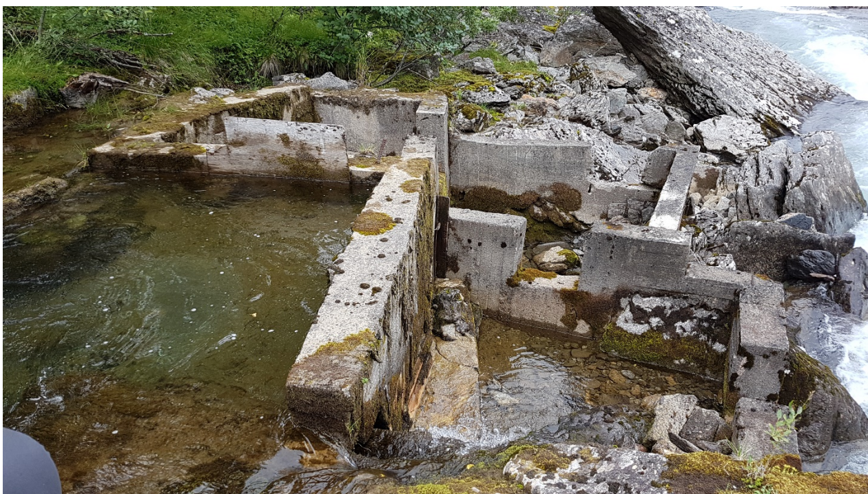
Figur 11. Nedre del av fisketrappa i Øverfossen (uten vannføring), som ikke lenger er i bruk.
