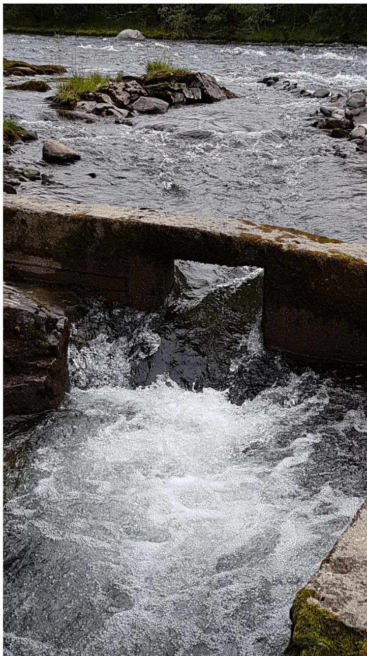
Figur 8. Vanninntaket til fisketrappa i Brufossen.
