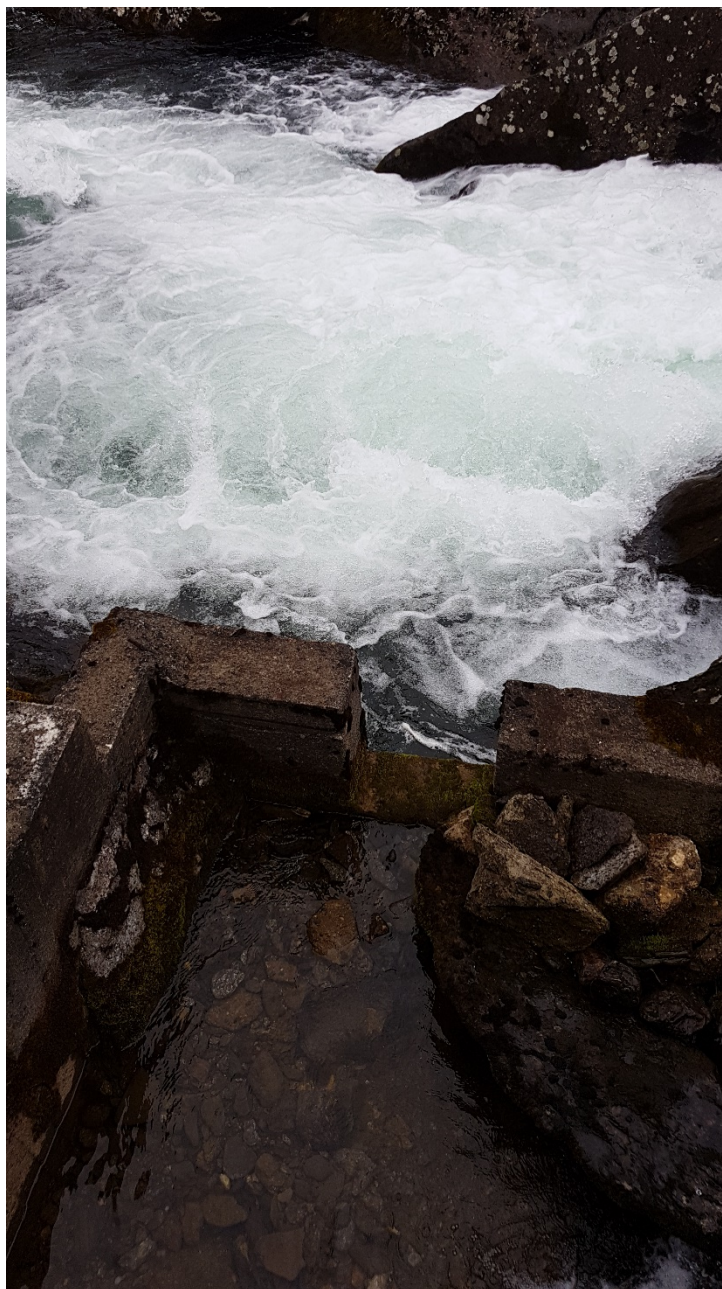
Figur 15. Inngangen til trappa i Øverfossen.
