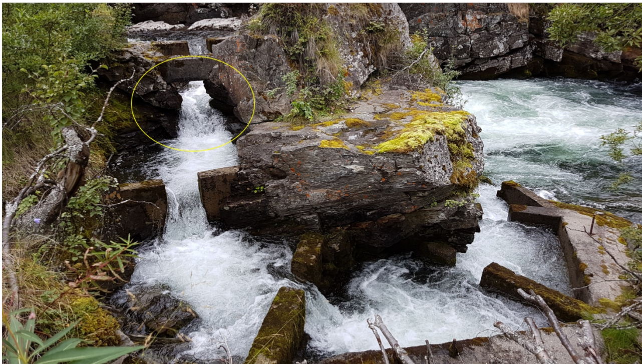
Figur 6. Laksetrappa i Brufossen. Terskel 6 (angitt med gul sirkel) ser ut til å være ødelagt.
