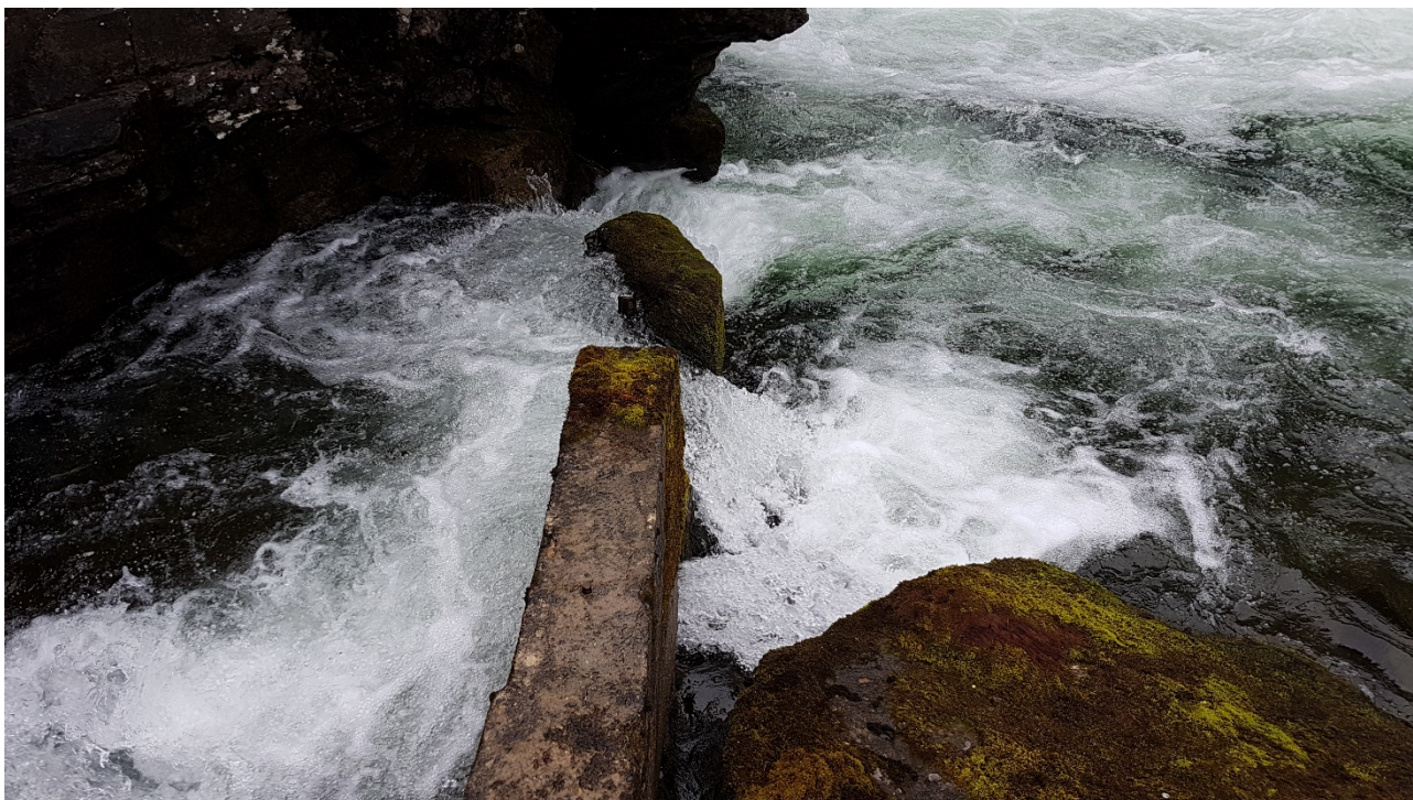
Figur 5. Inngangen til trappa i Brufossen er delt i to strømmer, separert med en betongblokk.
