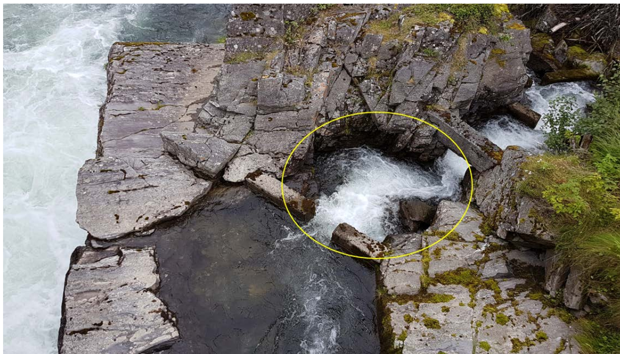
Figur 14. Kulp 6 markert med gul sirkel. Utløpet av denne kulpens bør støpes opp for å øke kulpens vannvolum og etablere en mer konsentrert vannstråle ut.
