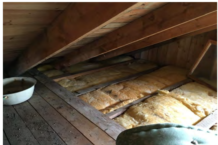
Fra gangen i første etasje kan man gå opp trappen til loftet med de fire soverommene. Her er det en luke opp til kryptloftet slik at man kan få inspisert isolasjon og skorstein. Det fins også ett vindu i hver gavl for utvendig inspeksjon.
