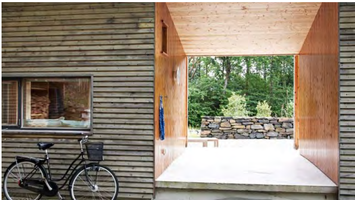
Tilbygg i malmfuru med liggende panel behandlet med jernvitrol. Arkitekt ukjent. Kilde: https://no.pinterest.com/pin/134545107597759119/
