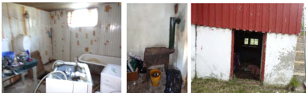
Det er kjeller under hele huset, med bad og wc, vedovn, brønn og boder. I tillegg er det atkomst utenfra til vedbod under bislag.
