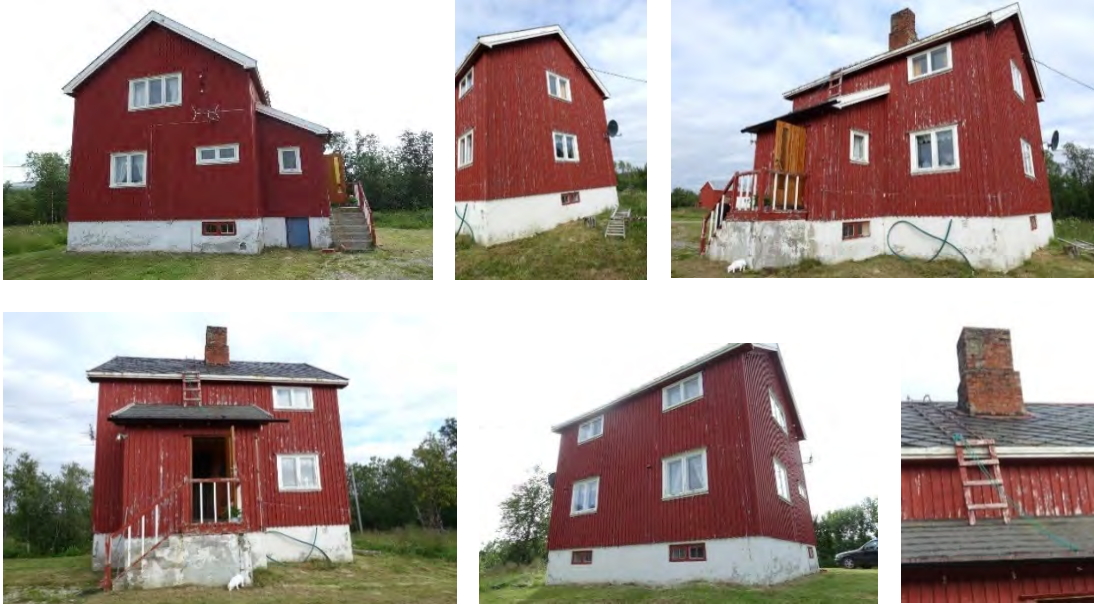
Huset i Børselv. Øverst til venstre gavlf mot nord, videre gavlf mot sør, bislag med inngang mot vest, fasade mot sør. Bislag med takpapp, hovedbygg med skifer, pipe i tegl.
