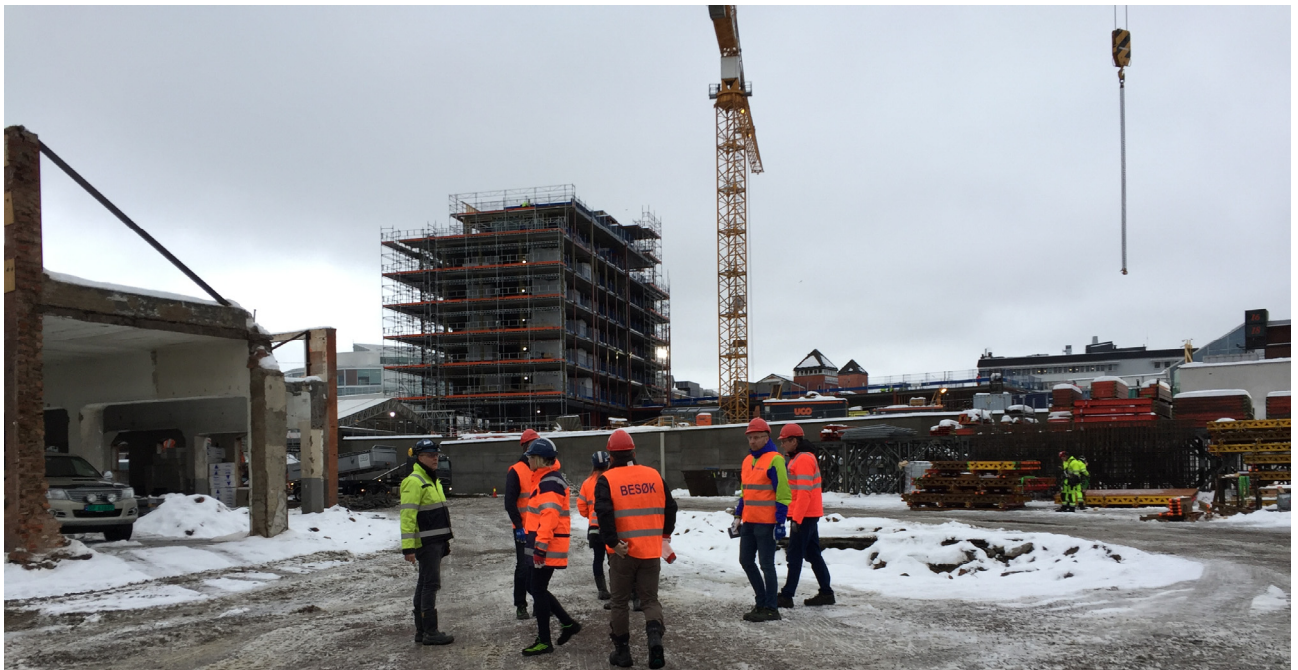
Figur 1.5. Bilde fra befaring hos Skanskas prosjekt Ensjø Torg, 24.1.2018. Foto: SINTEF
