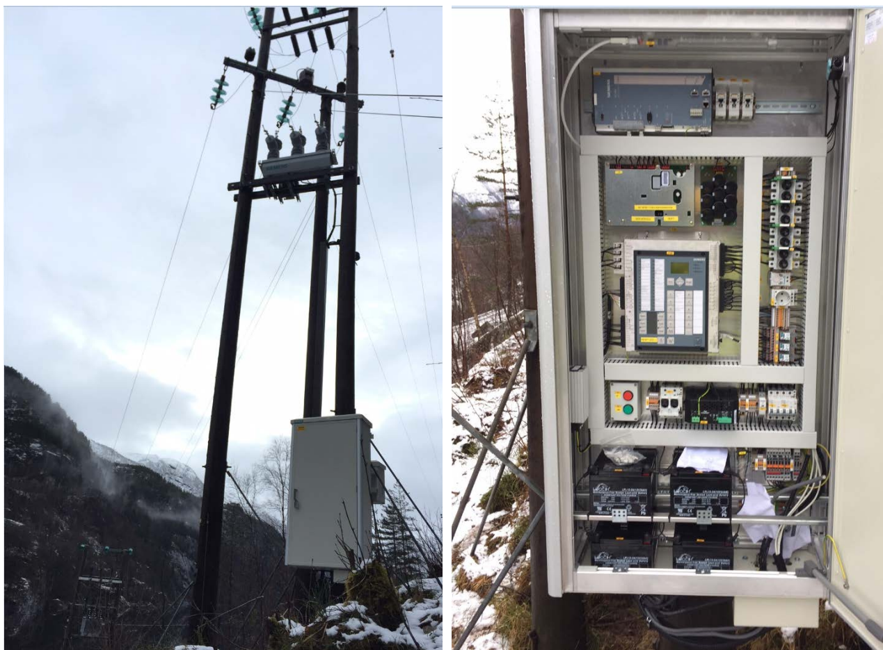
Figur 4.6 FLISR-løsning installert i Eksingedalen
