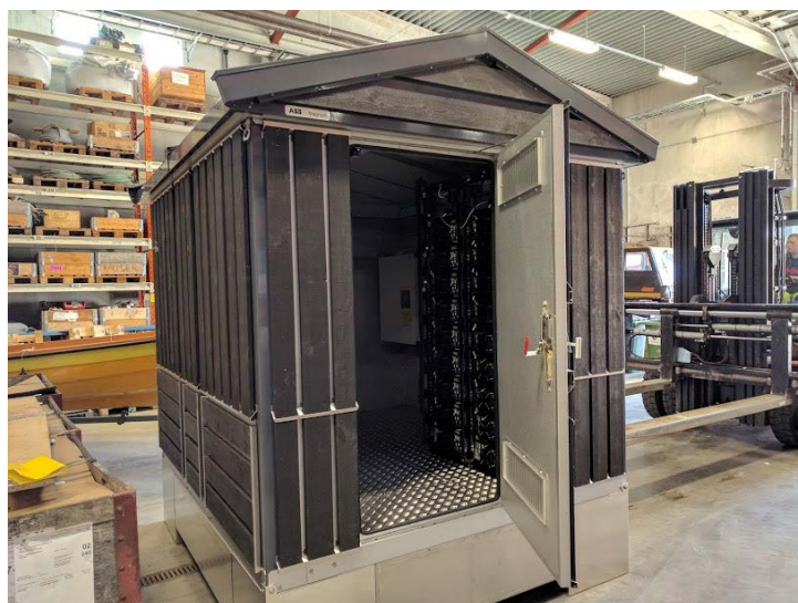
Figur 3.7 Nettstasjon som skal inneholde batteripakken
