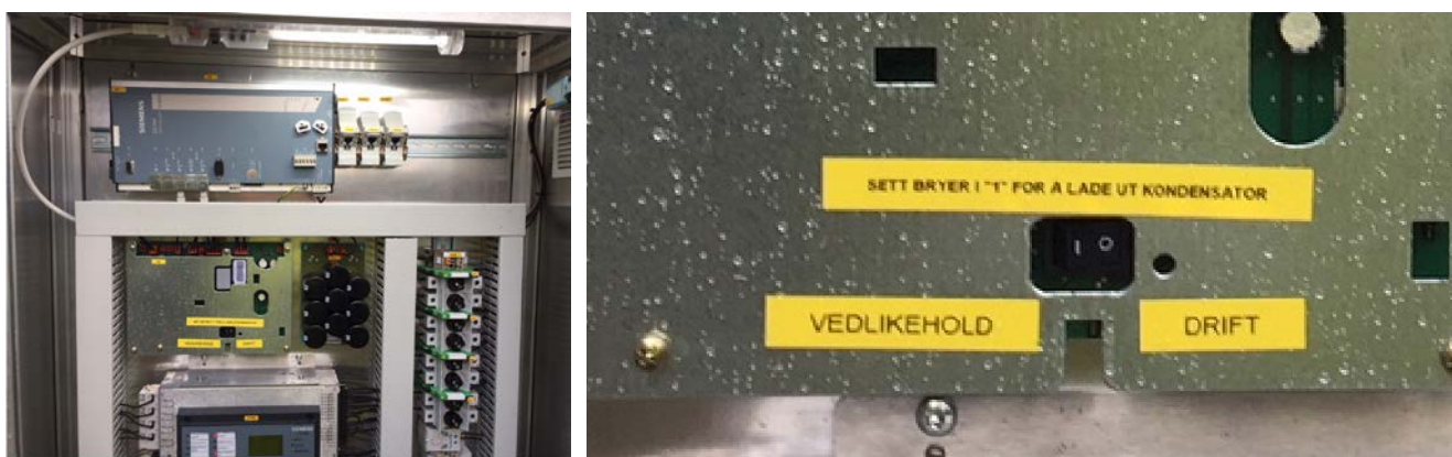
Figur 4.7 Merking av kondensator i effektbryter
