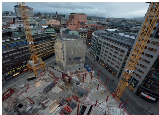
En byggeplass medfører mye aktivitet. God planlegging kan generere mindre støy, avfall og utslipp til luft og vann. Foto: Byggeindustrien
