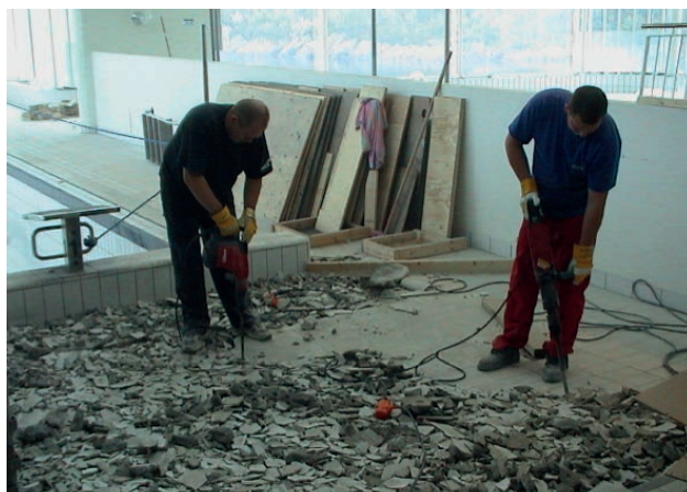
Demontering skjer enklest med meisle- og piggeutstyr
