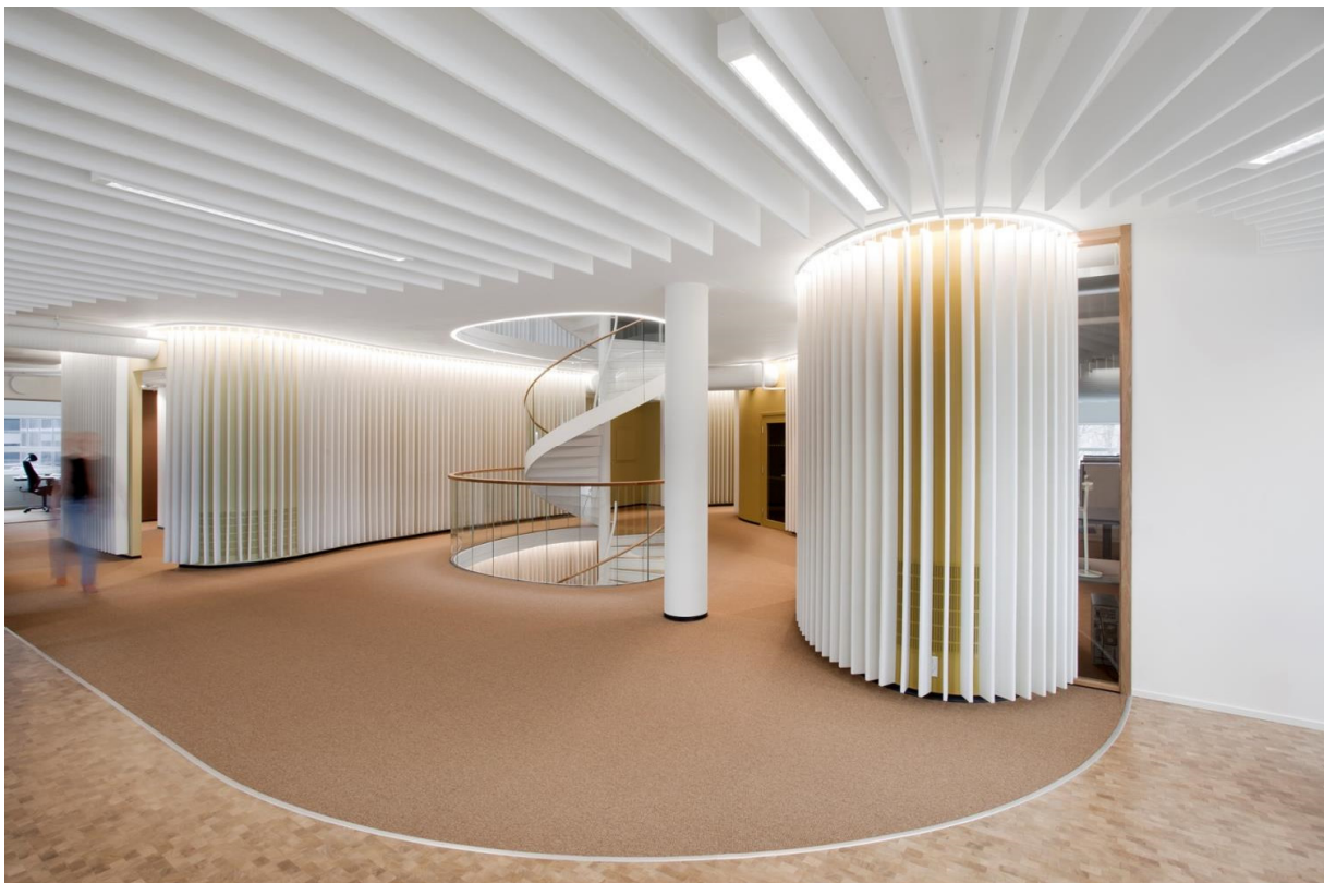
Figure 3.13 The acoustic baffles in Powerhouse Kjørbo. Photo: Ketil Jacobsen / Snøhetta.
