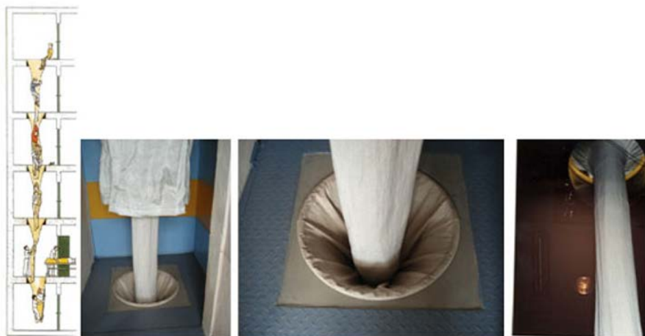
Figur 20. Prinsippskisse for bruk av innvendig redningsstrømpe i høye bygg
