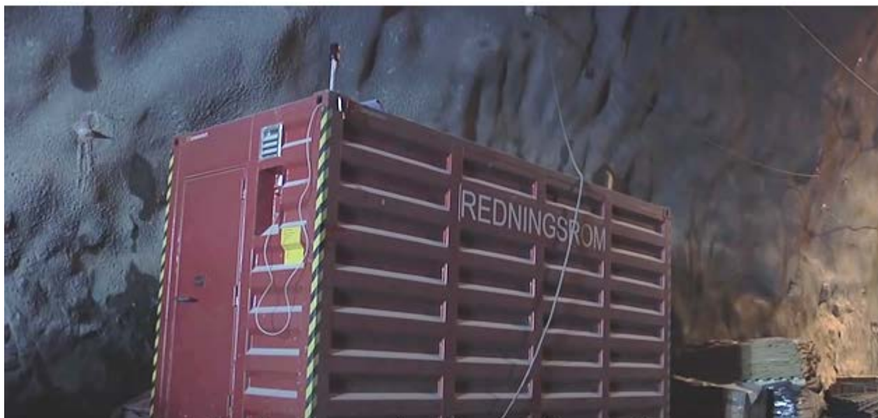
Figur 11. Redningsrom brukes ved byggefase for alle tunnelprosjekt i Norge. Her fra en opplæringsvideo Veidekke AS bruker overfor sine ansatte. Produsent av redningsrommet på bildet er Containertech. Foto: https://www.youtube.com/watch?v=esHroAciEsM&feature=youtu.be
