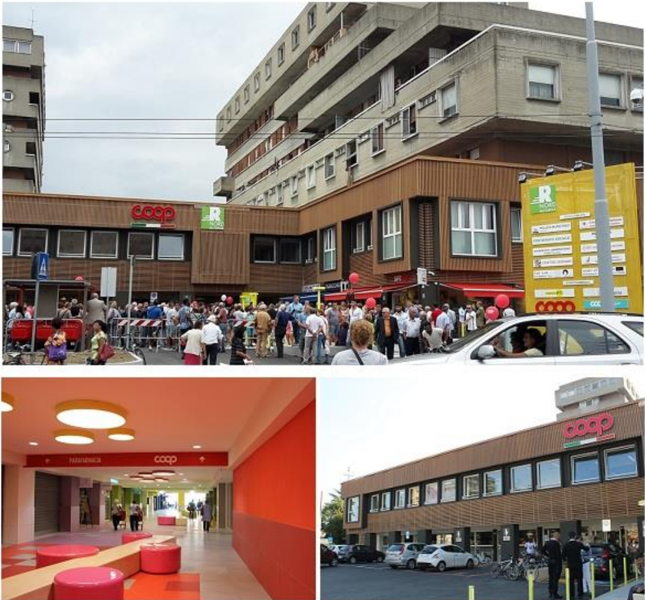
Figure 4-9. Coop Canaletto after retrofit.
