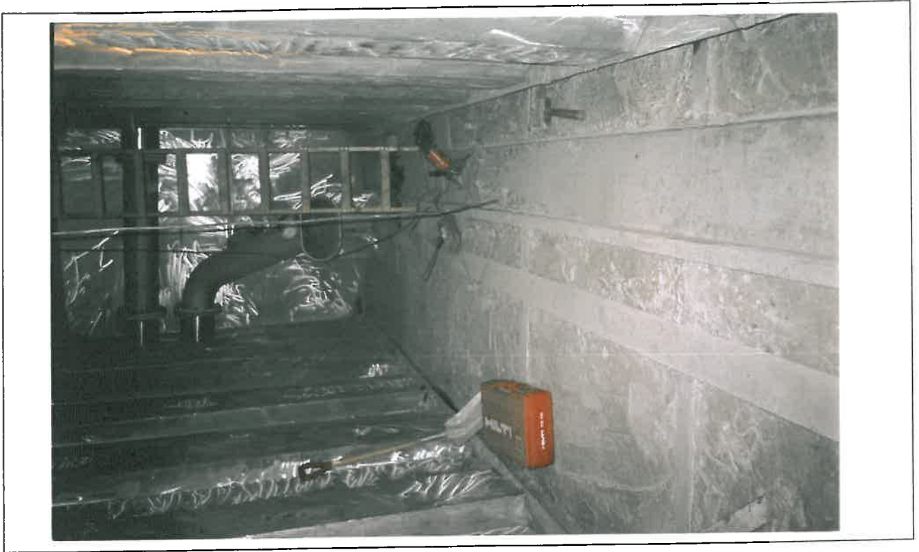
Bilde 13: Innlegging av fast ballast (blybarrer og betong) i senterrom på M/S "Korsnesfisk" av Båtsfjord, bygg nr. 190 ved Saltdalsverftet på Rognan, desember 1998.
