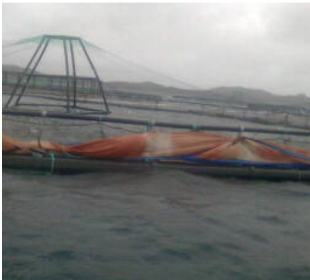
Figur 4 Skjørt kastet opp av sjøen og opp på flytekragen som følge av uvær.
