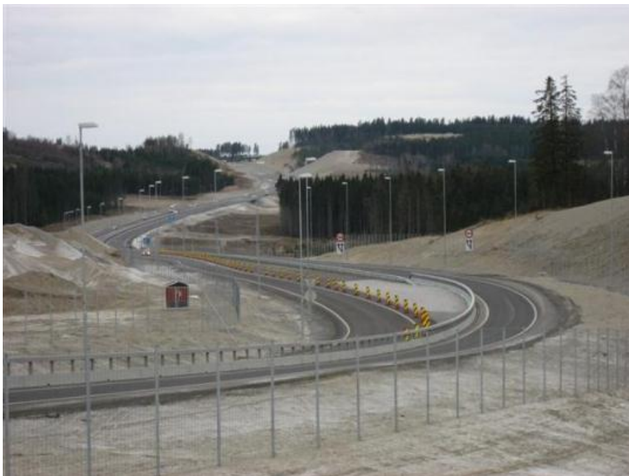
E18 gjennom Monaryggen. Foto: Statens Vegvesen
