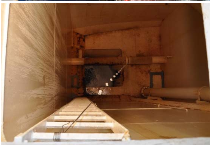
Bilde V1.2: Øverst: Ilandpumping av fisk. Nederst: Wire med temperaturloggere fra bunn til topp i lagringstanken.
