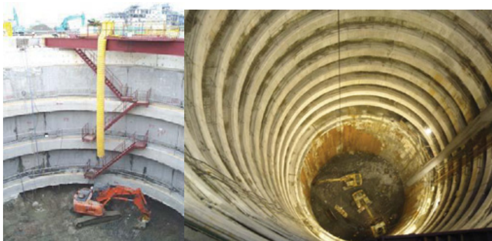
Figur 5 Til venstre vises en typisk seksjon av slissevegger og ringbjelker av betong; Til høyre sees overgangen mellom slissevegger og betong utstøpning (Tee et al. 2012)
