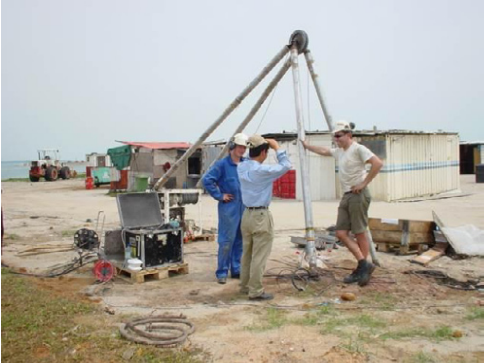
Figur 4 Utførelse av hydraulisk splitting (SINTEF Byggforsk)
