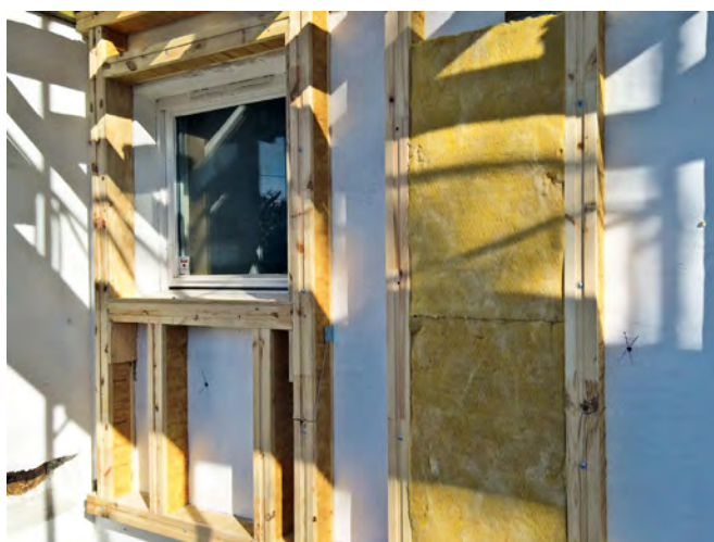
GLAVA Pluss system monteres på muren i sokkeletasjen.
