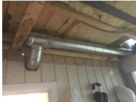
Kanaler i gangen før innkapsling
