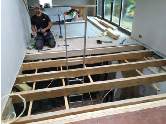
Åpning til ny trapp
