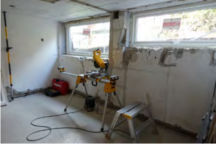
Nye vinduer i kjeller
