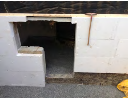
Ny inngang til kjeller
