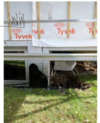
Isolasjon rundt veranda
