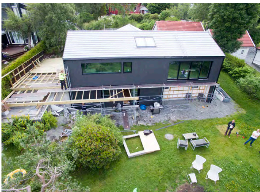
Oversiktsbilde mot slutten av byggeprosessen.
