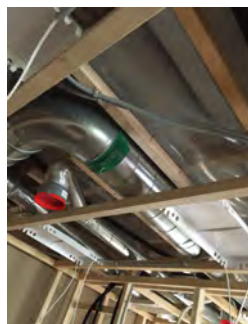
Rør i åpent dekke.
