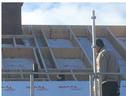
Etterisolering av tak med 300 mm I-bjelker
