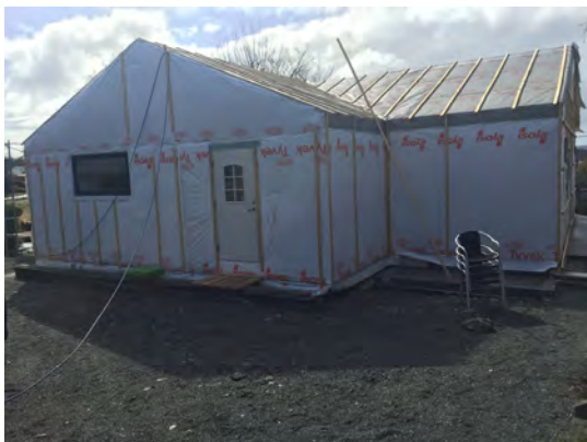
Kontinuerlig vindtetting for vegger og tak.
