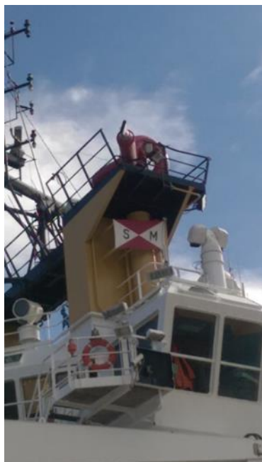
Figur 2.6 Plattform og rekkverk på MS Strilborg.
