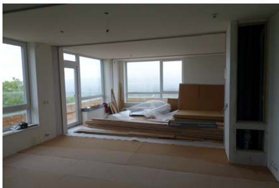
Fig. 11 For å få best mulig utbytte av dagslyset jobber arkitekt A konsekvent med vinduer som går til tak, og har fått gjennomslag for dette hos modulleverandøren.
