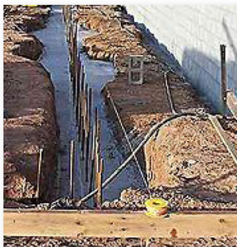
Fig. 17A: Spredte sålefundamenter.
