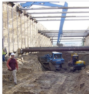
Fig. 19B og 19C: "Soldatbunker"; prinsippskisse og fysisk konstruksjon.
