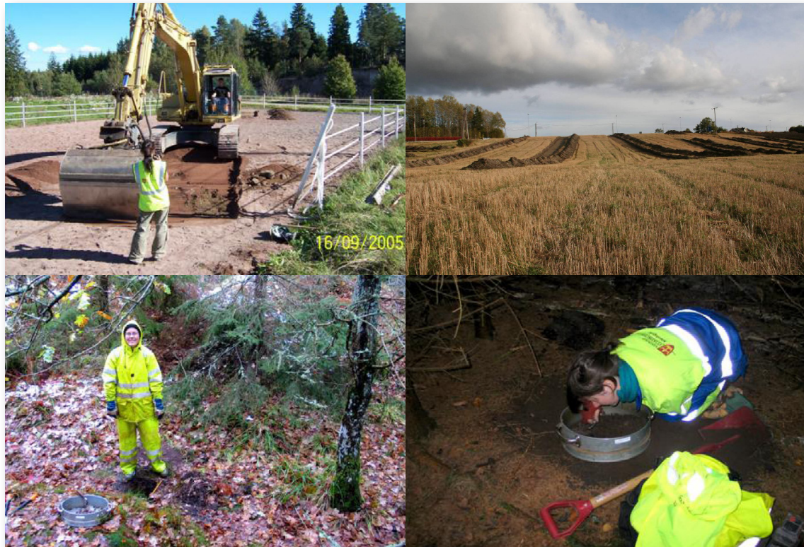
Fig. 49. Registreringer i Vestfold fylke i forbindelse med nye veiplaner for E-18 gjennom fylket. Foto: Vestfold fylkeskommune.
