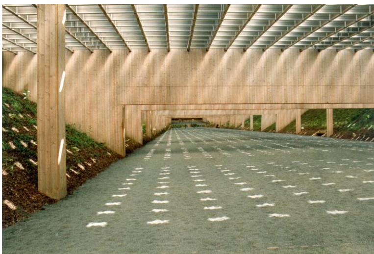
Figur 19. Skytebane med overdekking av absorberende raster [5]
