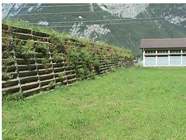
Figur 17. Skjerm tett inntil prosjekttilbanen gir effektiv demping av prosjektillyd [5]
