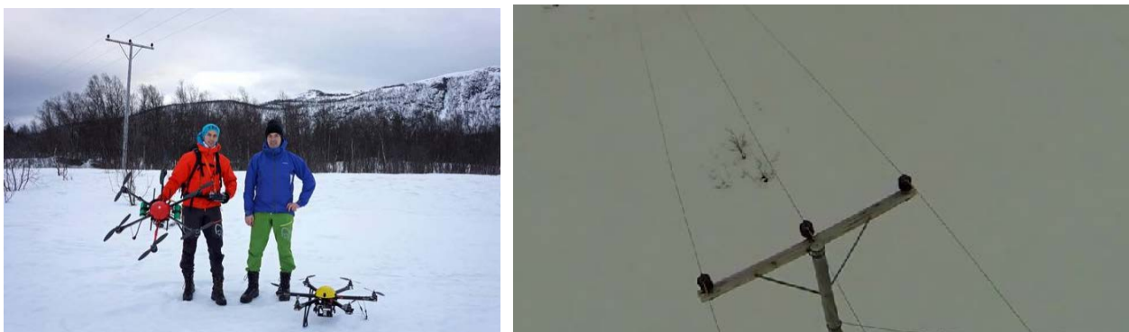
Figur 13: Inspeksjon av kraftlinjer © Hålogaland Kraft.
