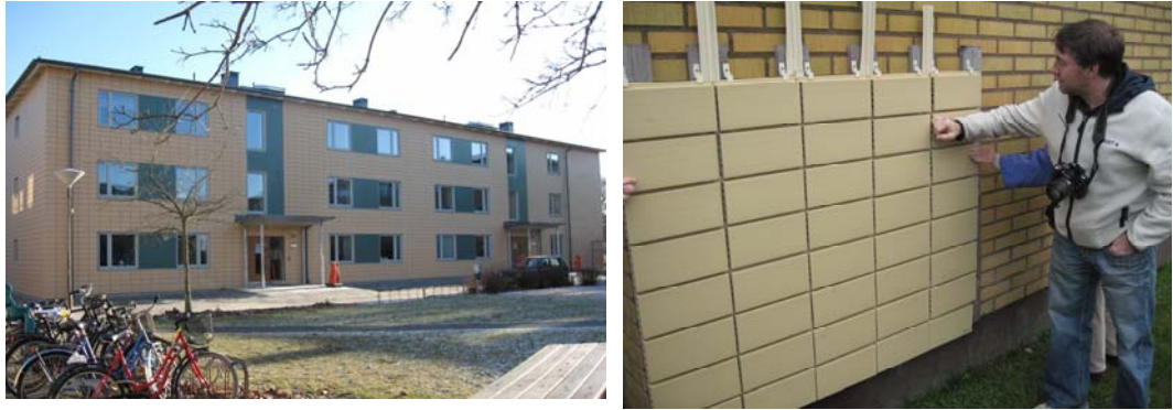
Figur 11: Rehabiliteringen innebærer blant annet omfattende bytte av fasadematerialer og vinduer.
