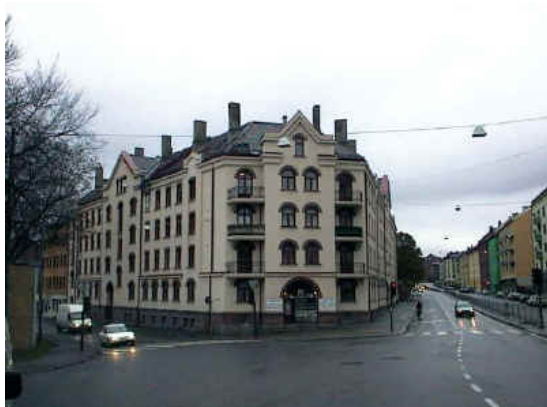
Figur 1: Åkebergveien 50, Det første kommunale boligbygg, Christiania 1902.. Arkitekt: Henrik Nissen
