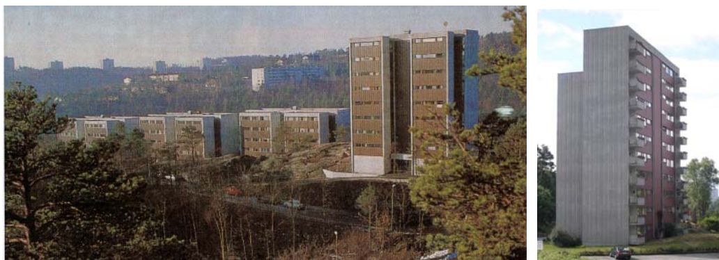
Figur 9: Tinnbo borettslag, Tinnheia, Kristiansand. Ferdigstilt i 1975. Arkitekt Brantzeg & Haugen Arkitektkontor. Størrelse: 10 274 m 2 fordelt på 11 bygninger: 1 blokk på 11 etasjer, 1 blokk på 8 etasjer, 9 lavblokker på 4 etasjer. Spesifikk energibruk: 320.7 kWh/ m 2 år. Borettslaget ønsker å rehabilitere fasadene. Utfordringen blir å finne en løsning for etterisolering og samtidig beholde det arkitektoniske uttrykket.
