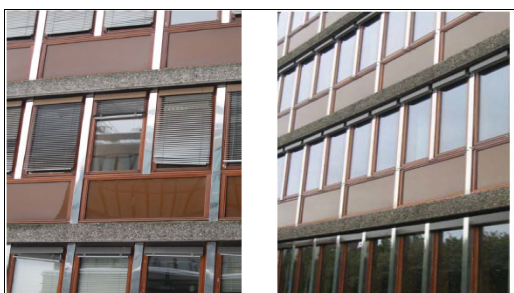
Bilde 5. Fasade før og etter ombygging. Eksisterende, utvendige persienner er skiftet. Karm og ramme i vinduer er beholdt, mens ruten er skiftet. Siden fasaden er fredet er det ikke gjort andre endringer.
