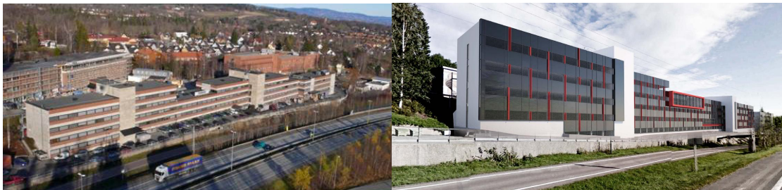
Bilde 9 Solbråveien 23 før og etter oppgradering. Utvendig kledning på fasadene er skiftet ut.
