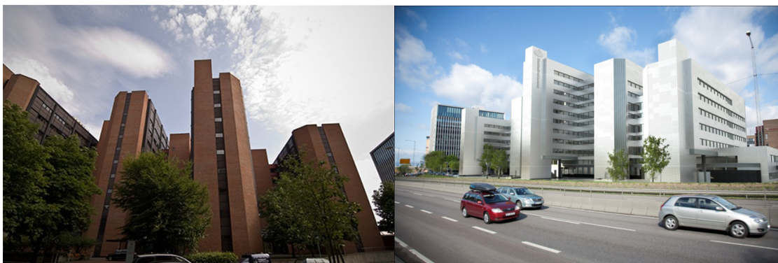
Bilde 1 Fredrik Selmers vei før og etter rehabilitering
