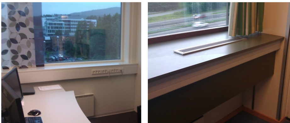
Bilde 10 Utskifting av vindusapparater ga bedre plassutnyttelse i kontorene
