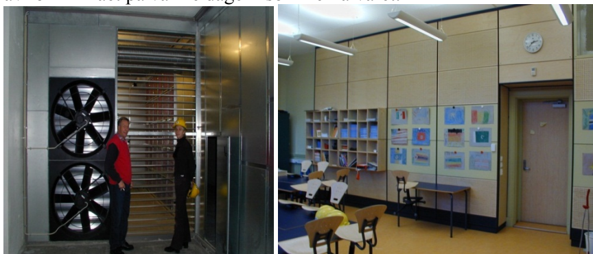
Bilde 8 Betongkulvert med vifter til venstre, installasjonsvegg i klasserom til høyre
