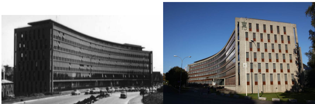
Bilde 4. Middelthuns gate 29, før (t.v) og etter (t.h.) rehabilitering
