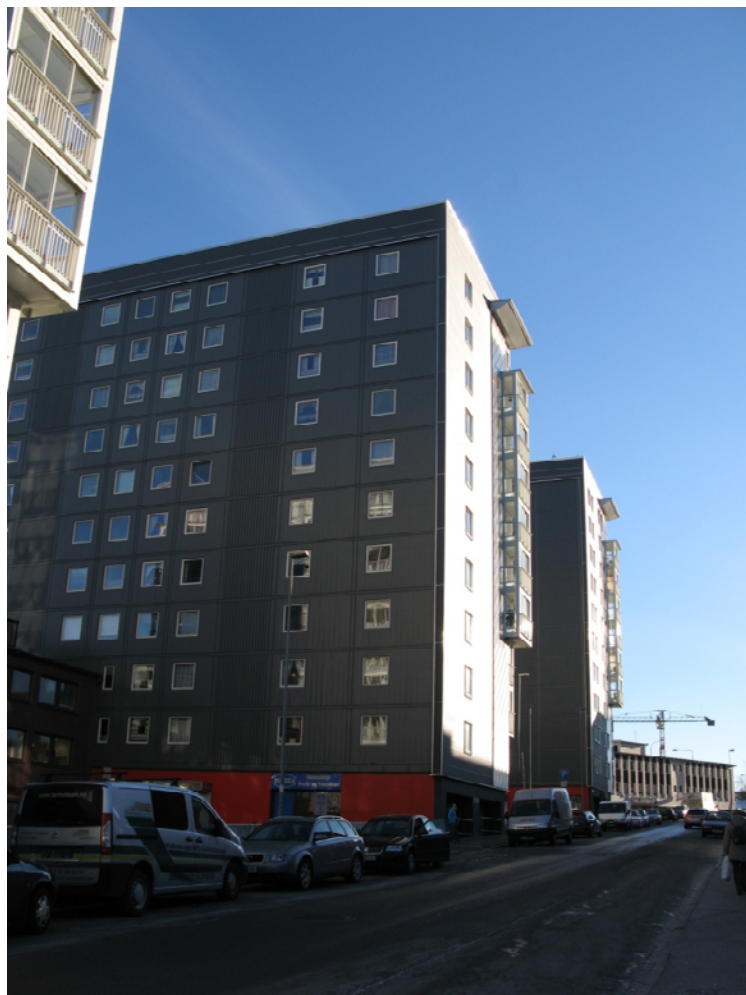
Nye fasader mot nord. Foto: SINTEF Byggforsk.
