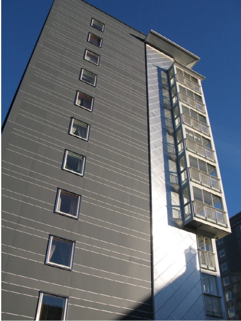
De nye gavlveggene, høsten 2010. Foto: SINTEF Byggforsk
