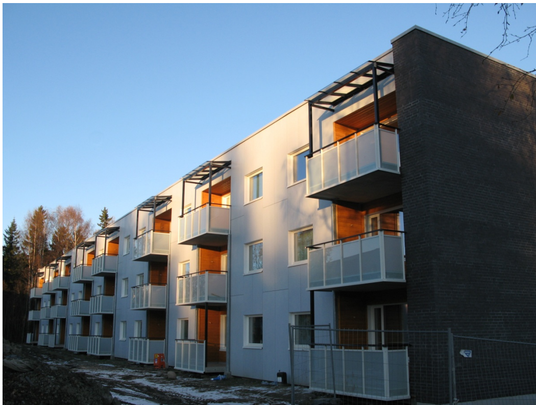
Myhrerenga borettslag etter oppgradering vinteren 2010. Foto: SINTEF Byggforsk.
