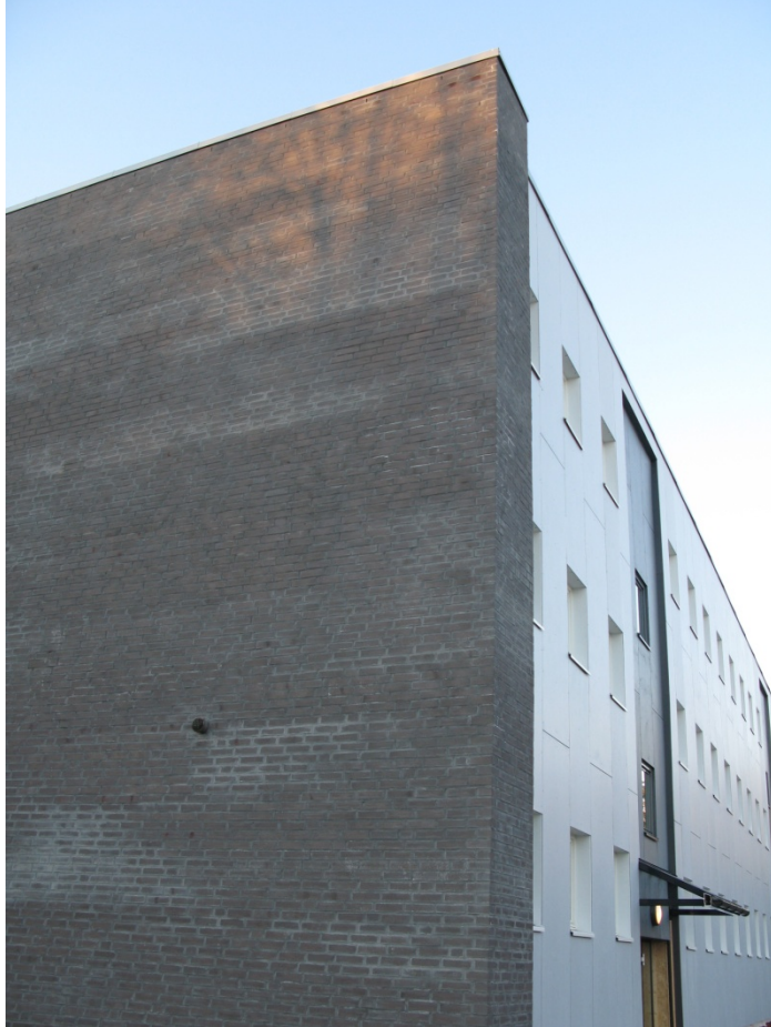
Inngangsparti på en av blokkene etter oppgradering. Foto: SINTEF Byggforsk.
