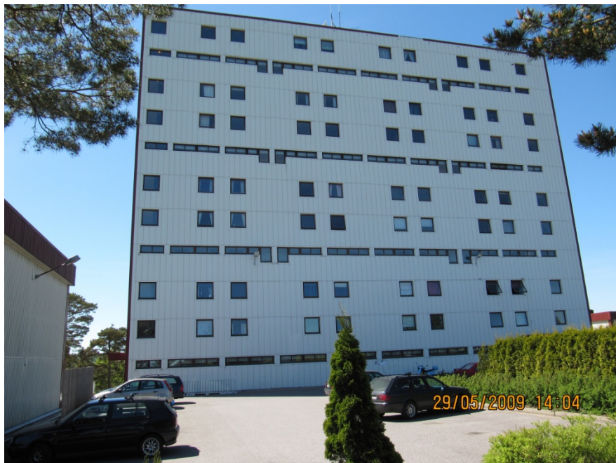
Gullveien borettslag pr. 2010, høyblokk. Foto: Boligbyggelaget.
