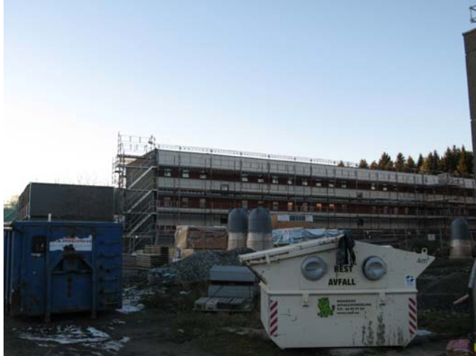
Myhrerenga borettslag under oppgradering. Foto: SINTEF Byggforsk.
