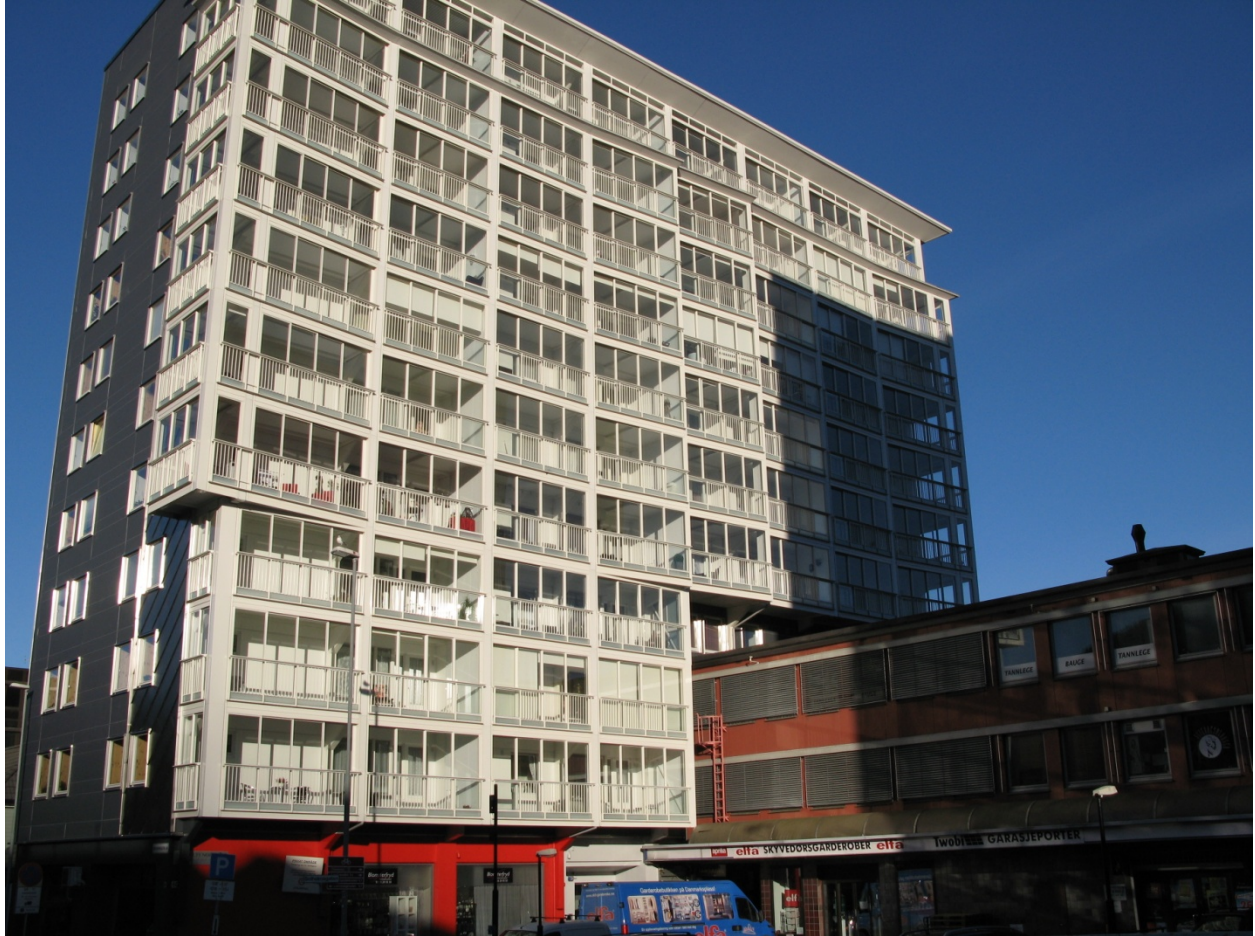
Ny fasade – 2010. Foto: SINTEF Byggforsk.
