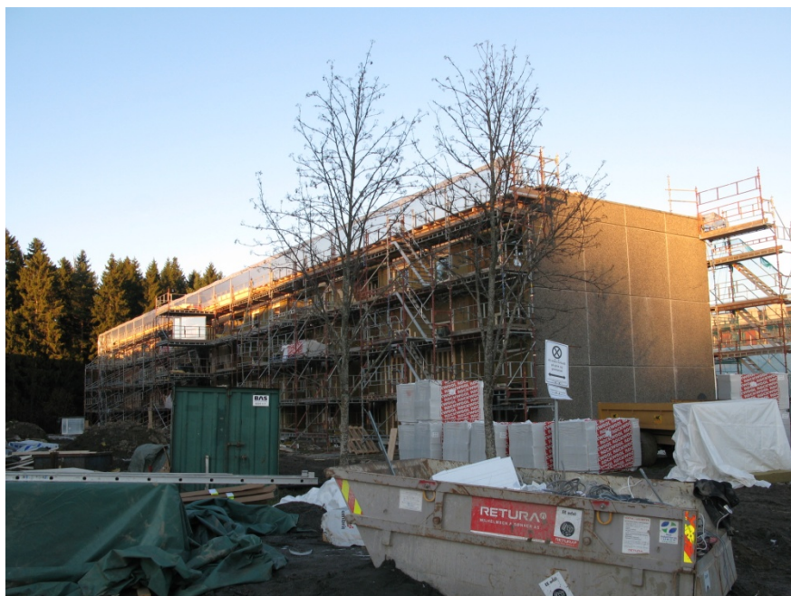
Myhrerenga borettslag under oppgradering. Foto: SINTEF Byggforsk.
