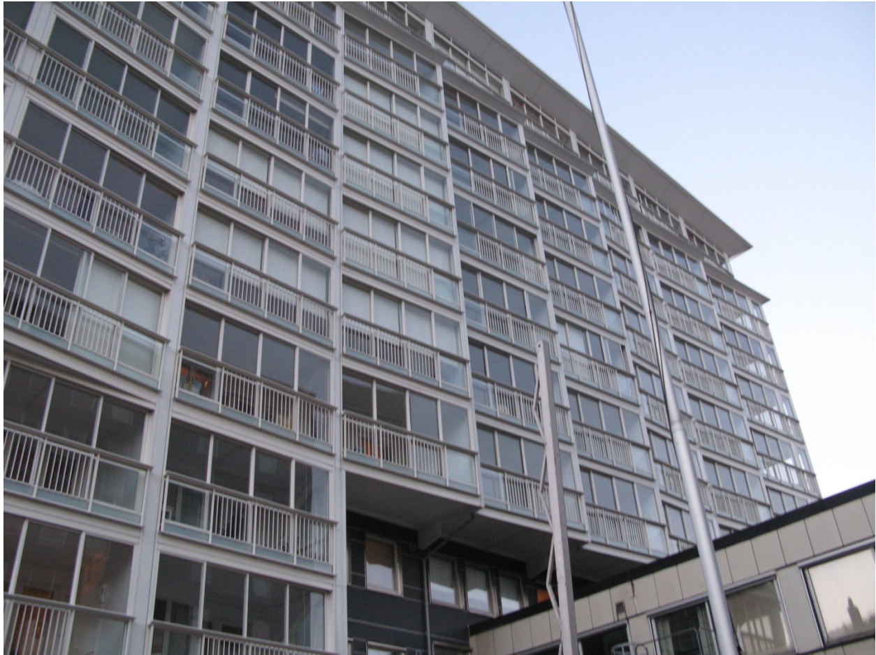
Nye innglassede fasader. Foto: SINTEF Byggforsk.
