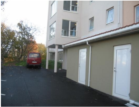
Inngangsparti etter oppgradering.
