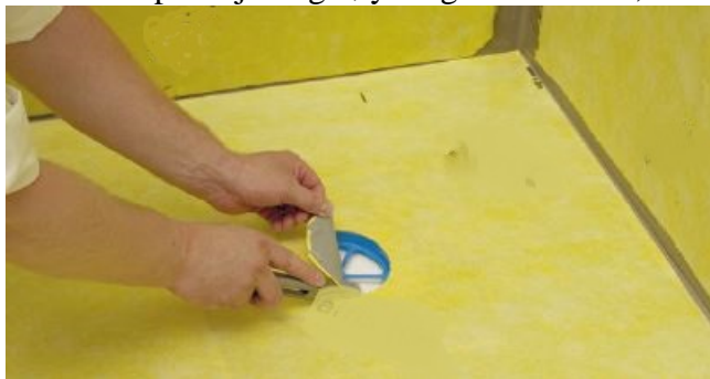
Figur 6: Det skjæres ut åpning i duken tilpasset slukstørrelsen før mansjetten monteres.
