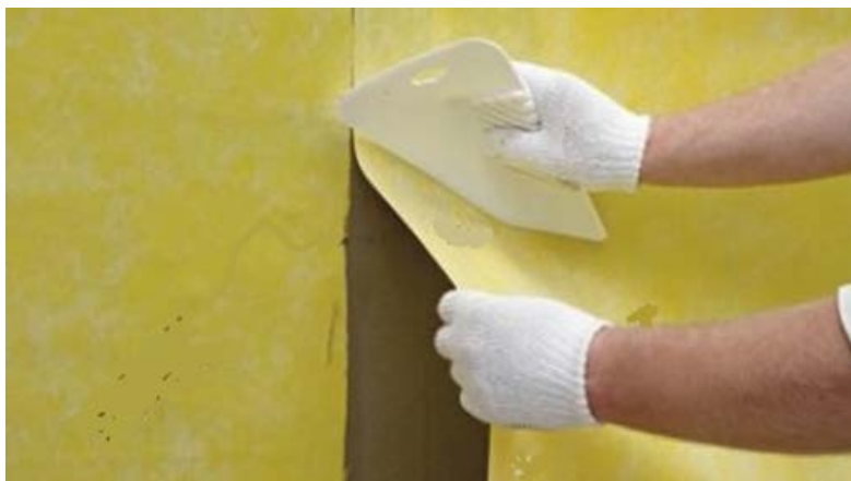
Figur 3: Ulike leverandører har valgt noe forskjellige skjøte- og sammenføyningsløsninger.
