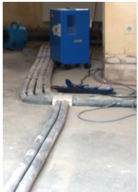
Figur 3: Trebaserte golvmaterialene ble fjernet til ned på betongen og kraftige byggtørkere ble brukt for fuktjerning.
