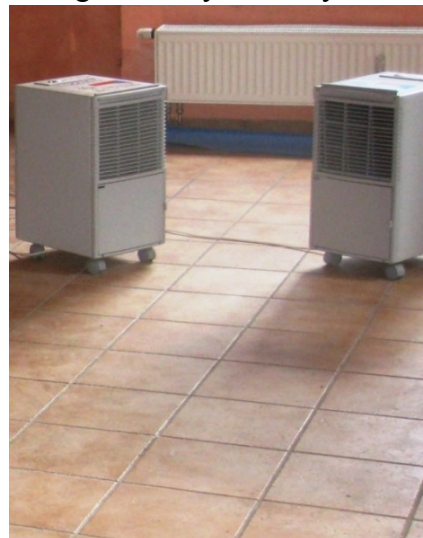
Figur 5: Det rengjorte golvet fikk stå og tørke noe tid og ble så tatt i bruk igjen.
