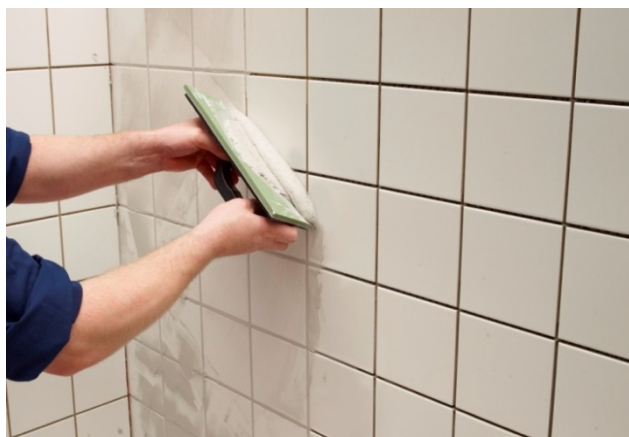
Figur 1: Fargevariasjoner i fugede flisflater kan unngås ved korrekt blanding samt kontroll av fukt- og temperaturforhold.
