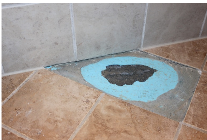
Figur 1: Membraner på våtromsgolv lar seg skjøte med egnede materialer og av erfarne håndverkere.
