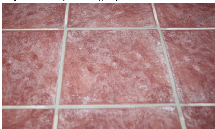
Figur 3: Når fugemasser er ferdig uttørket blir den lysere og skal da gå i ett med den eksisterende fugen.
