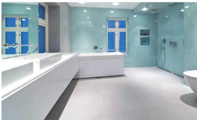
Figur 1. Bad med badekar har behov for flere sluk som må plasseres iht. fallplaner
