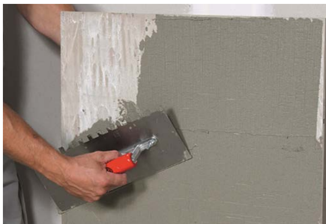
Figur 4: Dobbellinging tar litt ekstra tid, men øker vedheften og kvaliteten.
