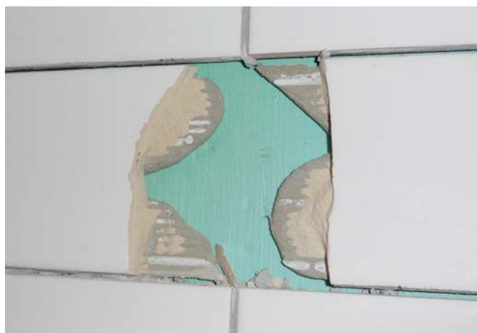
Figur 5: Lim skal påføres og kammes ut på underlaget, ikke legg lim på flisen alene som her er gjort.
