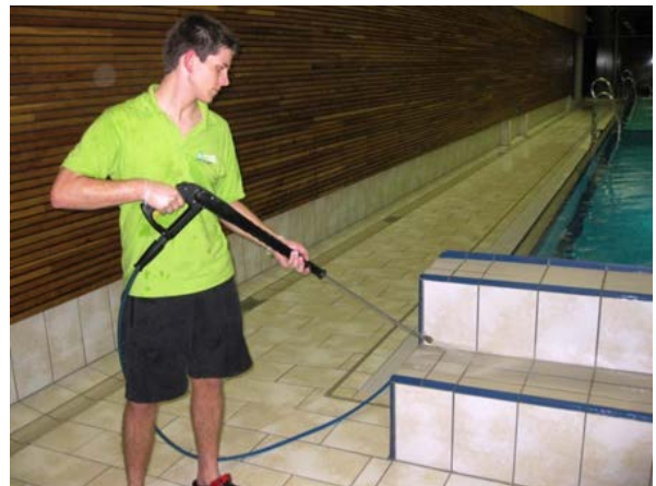
Figur 8 a og b: Rengjøringsmetoden er avgjørende for bestandigheten av fugene. Kraftig høgtrykkspyling, harde hjul og stive børster reduserer fugenes levetid.
