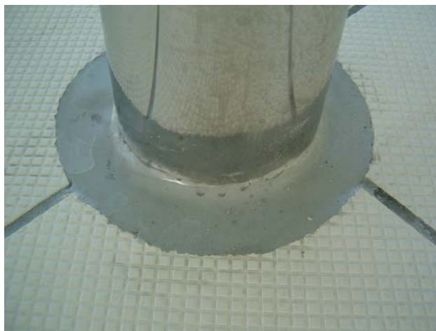
Figur 3: Typisk fuge med fargeendring grunnet mikroorganismer.
