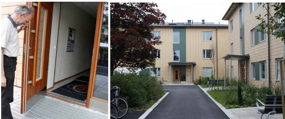
Brogården, inngangsparti med lave terskler. Foto: SINTEF Byggforsk
